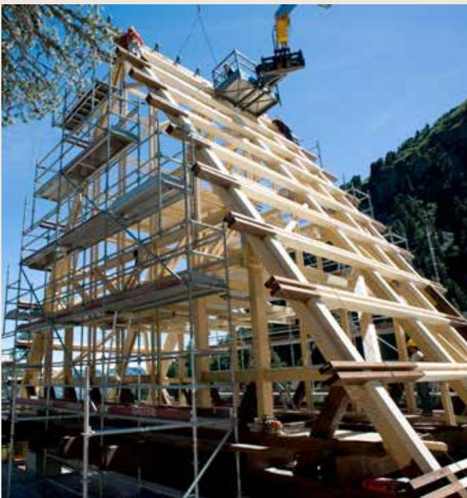
Numerosi elementi strutturali del telaio portante rimangono alla fine occultati all'interno dell'involturo termicamente performante, concepito per portare l'edificio alla massima efficienza.
